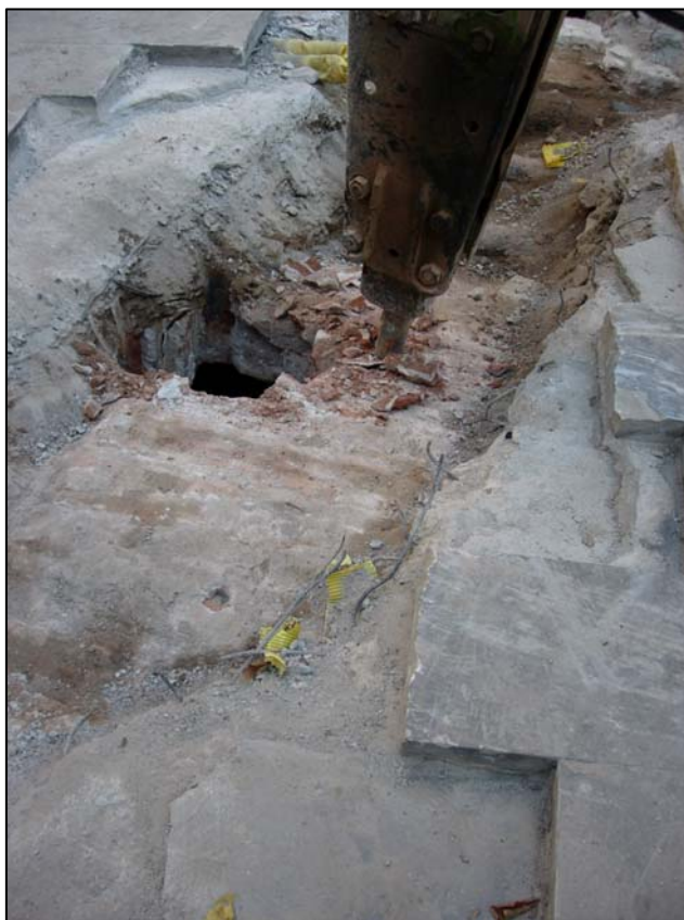
Foto 6: Procés de desmuntatge de la volta de la claveguera (UE 01).
