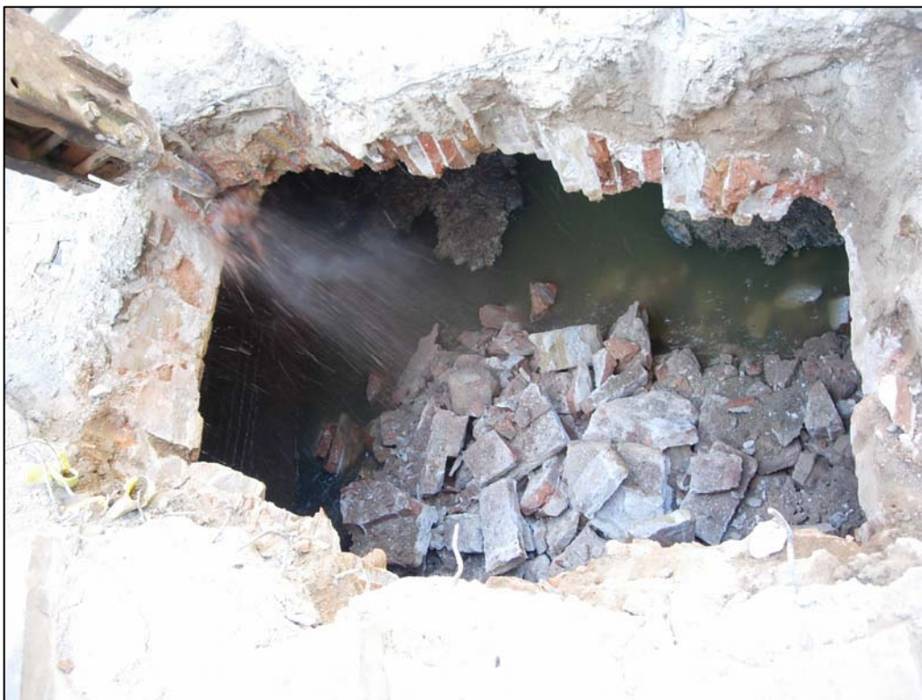
Foto 7: Procés de desmuntatge de la volta de la claveguera (UE 01).
