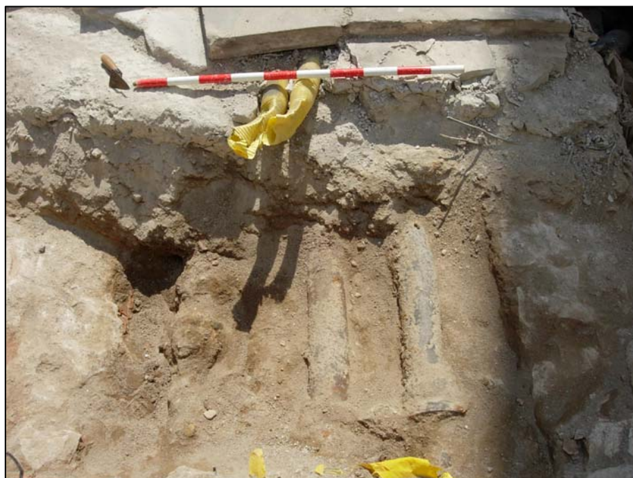
Foto 4: Vista de la part nord de la volta de la claveguera (UE 01) on es veuen el diferents serveis que afecten parcialment a la volta.
