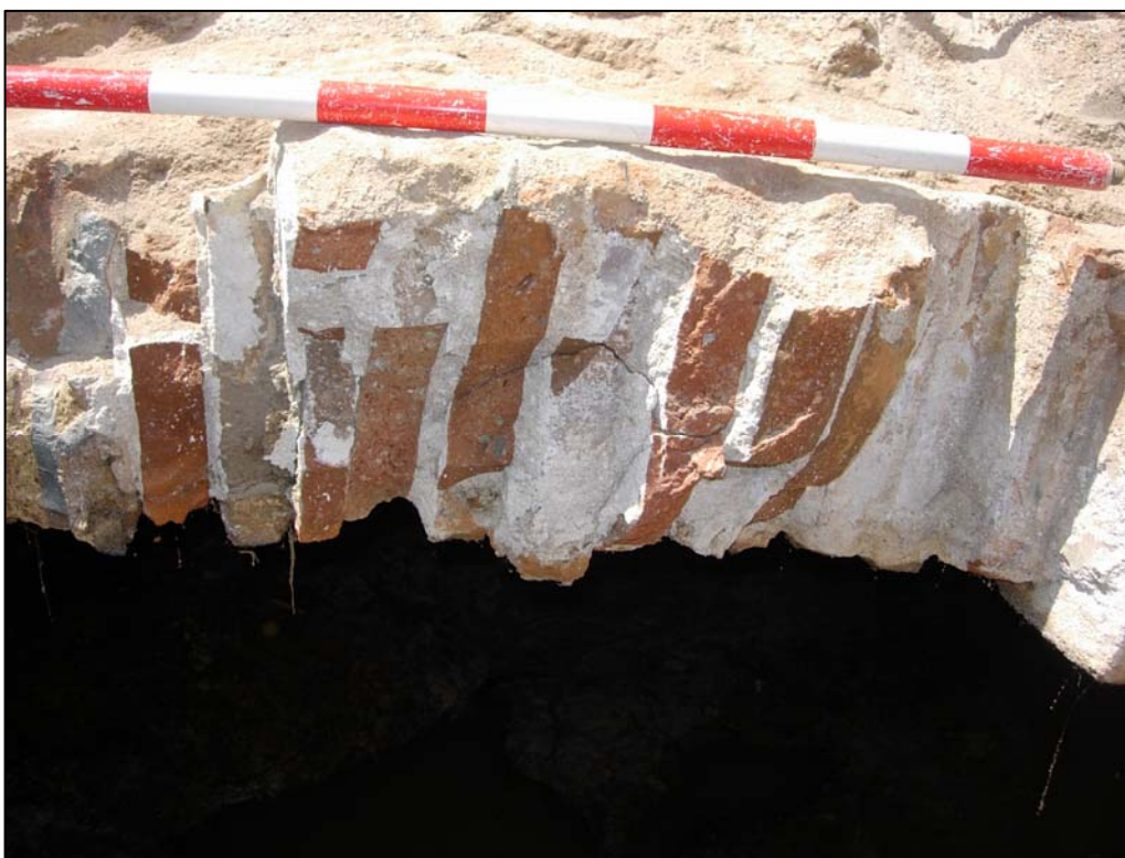
Foto 8: Vista des de l'est: detall del perfil de la volta de la claveguera (UE 01).
