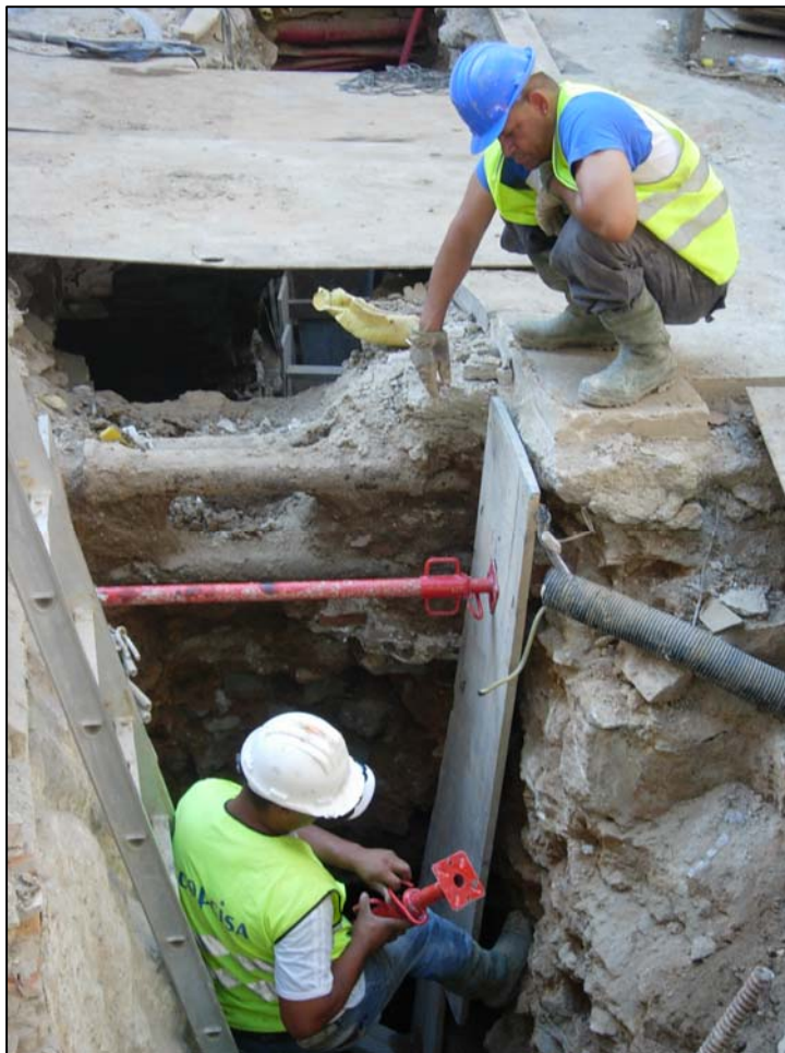
Foto 17: Procés d'apuntament de la rasa.
