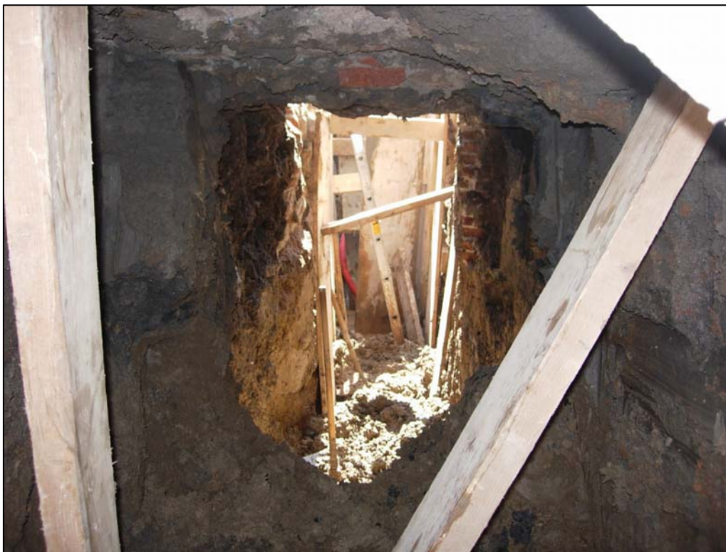
Foto 19: Vista de la mina per sota de la claveguera (UE 01).
