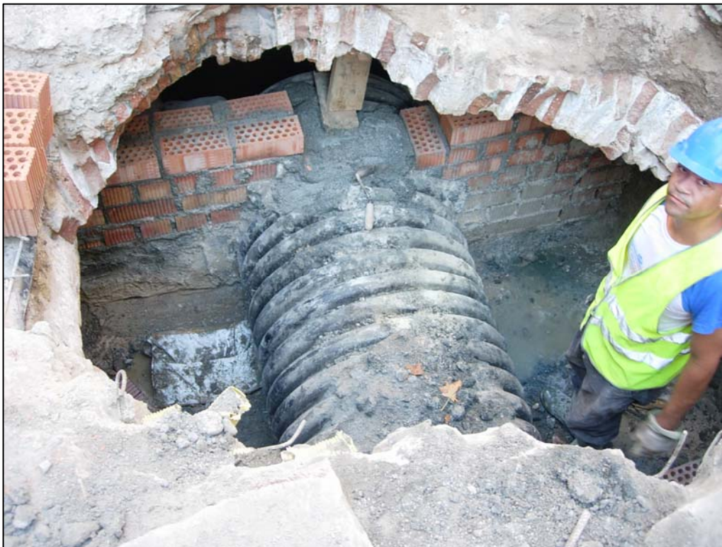
Foto 15: Detall del procés de les obres per realitzar el desmuntatge i minat de la claveguera (UE 01).
