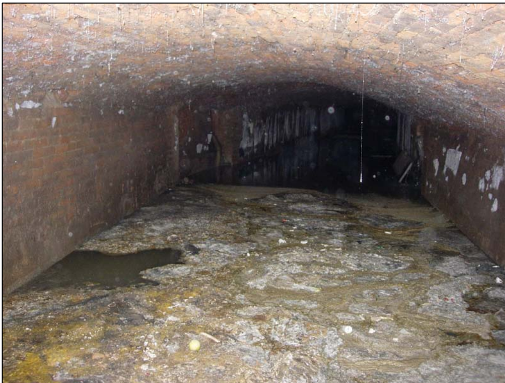
Foto 9: Vista de l'interior de la claveguera (UE 01) en funcionament.
