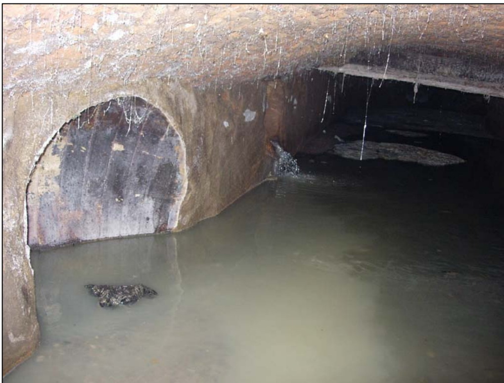
Foto 10: Vista de l'interior de la claveguera (UE 01) en funcionament.
