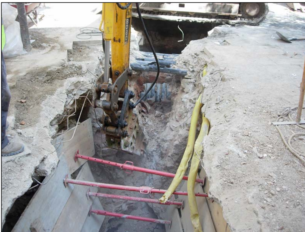
Foto 16: Procés de minat de la claveguera (UE 01)
