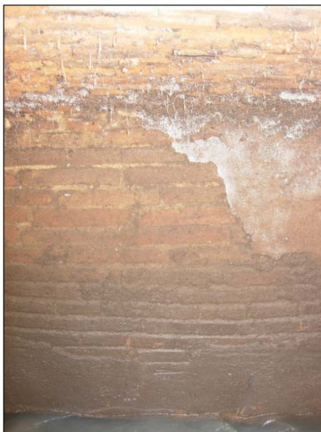
Foto 12: Vista de la volta i la paret des de l'interior de la claveguera (UE 01).
