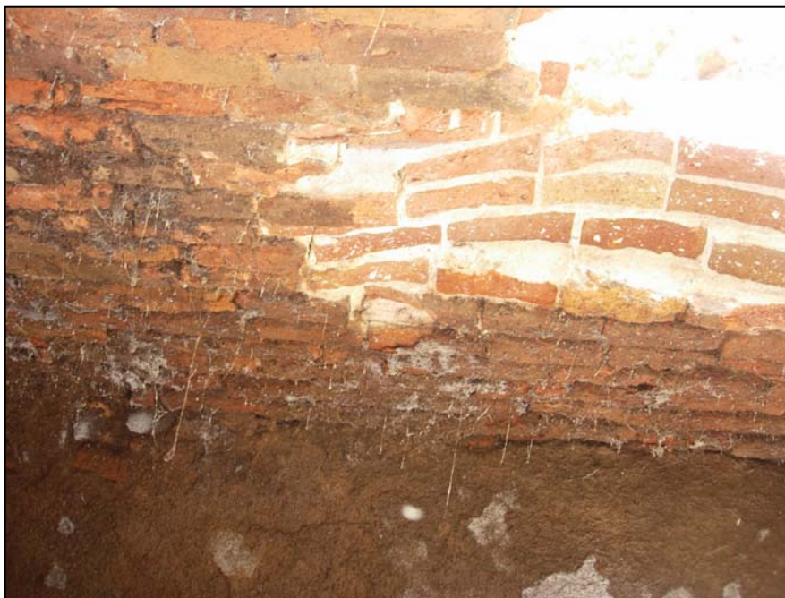
Foto 11: Vista de la volta (UE 01) des de l'interior de la claveguera.
